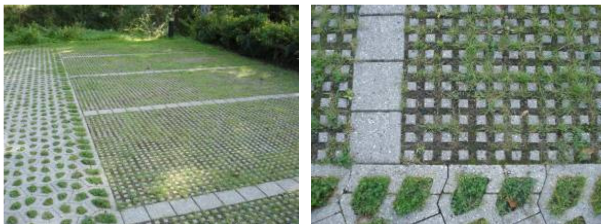
Eksempler på forskellige typer græsarmering, der tillader nedsivning af regnvand og samtidig markerer forskelle på manøvrearealer og parkeringsarealer.
