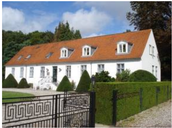
Bygning 2 – sidebygning mod nord
